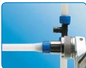
Расширьте конец трубы расширительным инструментом Uronor
